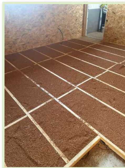
Utilisation de notre produit isolant Solidaliège pour isoler le sol de notre local à Duntzenheim.
